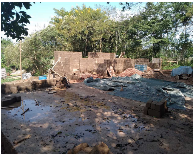
Baustelle des neuen Kindergartegebäudes.
